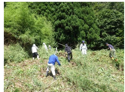
緩衝帯整備作業 (イメージ)
