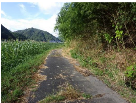
緩衝帯整備実施前
