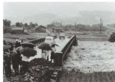
昭和37年 牛道川豪雨被災状況
