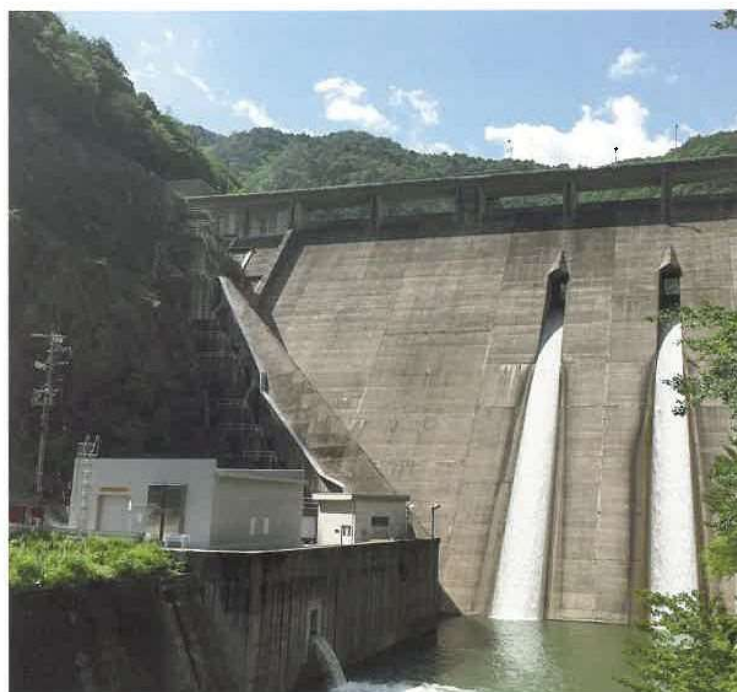
阿多岐ダムと水力発電所
