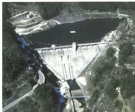
阿多岐ダム全景
