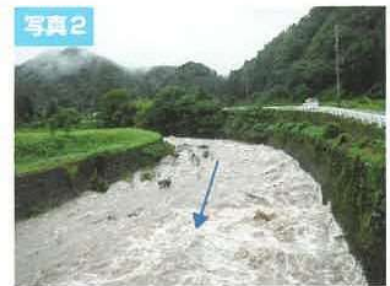
阿多岐川 見地橋上流の様子（平成26年8月17日）
