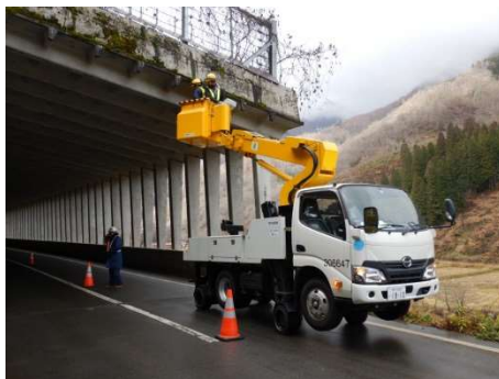
高所作業車による点検
