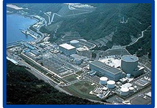
日本原子力発電株式会社 敦賀発電所*
