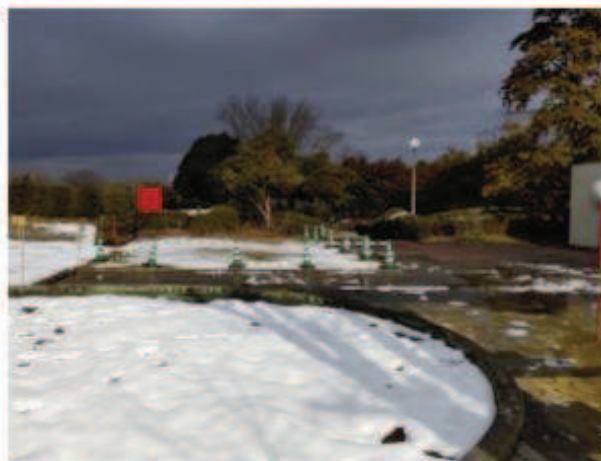
(危険建築物撤去後の状況)
