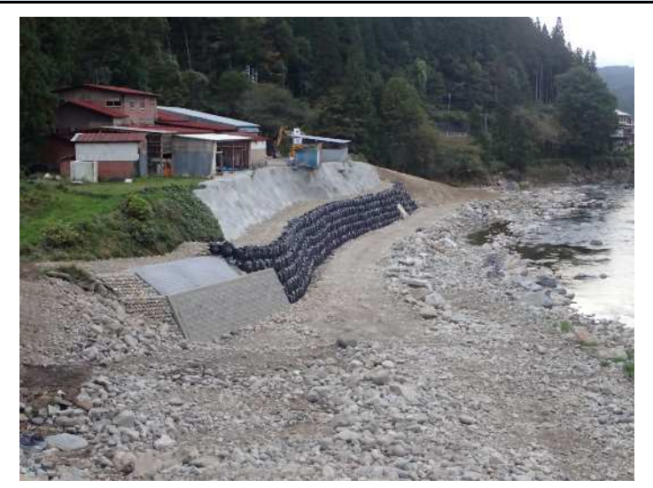
応急工事完了後
