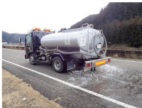
<散水車による消毒液散布>
