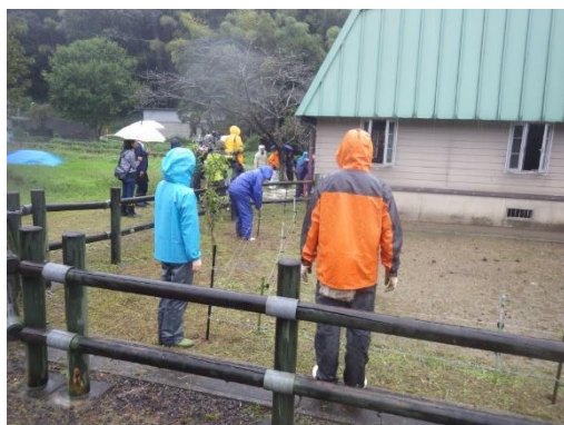
<電気柵の設置>
