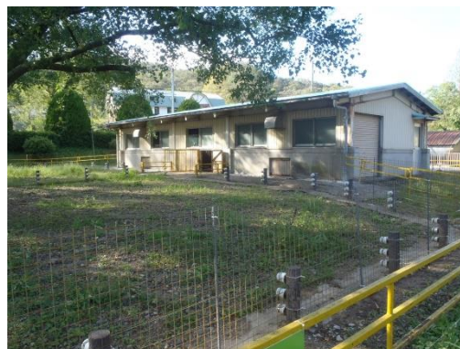
<電気柵・ワイヤーメッシュの設置>
