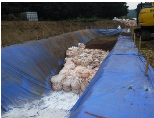
<フレコン投入・埋め戻し>
