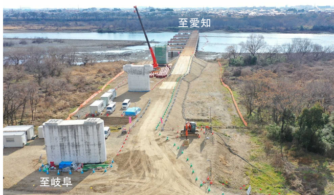
(一)扶桑各務原線 新愛岐道路 工事状況
