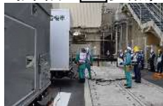
中国電力電源車接続訓練 (詳細は14参照)
