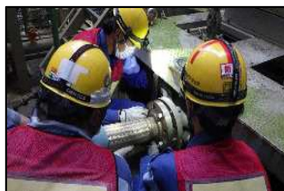
仮設中圧ポンプ接続訓練
