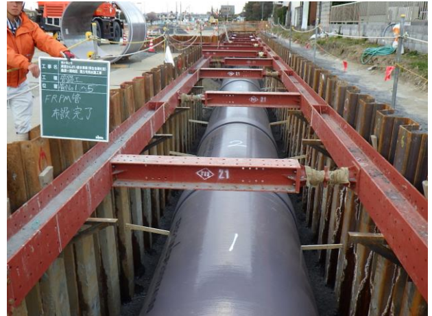
下流から望む (管敷設完了時)
