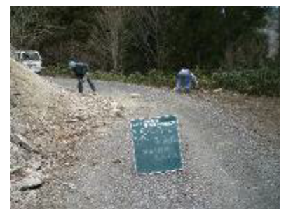
< 落石除去の状況 >
