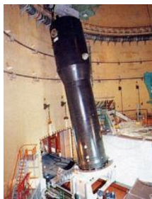
▲蒸気発生器の取替え
