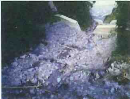
谷止工30基で15,000m 3 の不安定土砂を抑止(10tトラック約2,700台分)
