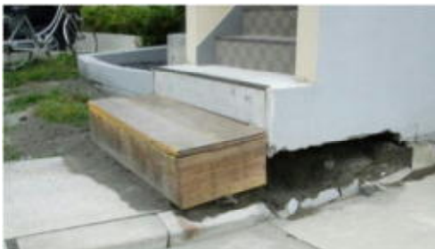
浦安市内被害状況（住居階段部の空洞化、マンホールの隆起、側溝のゆがみ等が発生）
