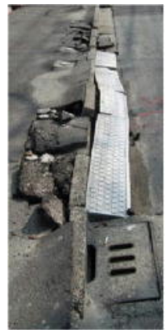
浦安市内被害状況（住居階段部の空洞化、マンホールの隆起、側溝のゆがみ等が発生）
