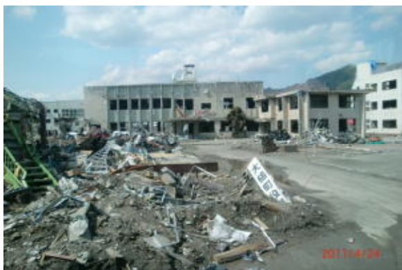
岩手県大槌町役場の被害状況
