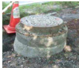
浦安市内被害状況（住居階段部の空洞化、マンホールの隆起、側溝のゆがみ等が発生）
