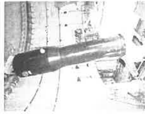
▲蒸気発生器の取替え
