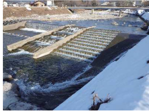
魚道の機能回復工事①(牛道川(郡上市))
