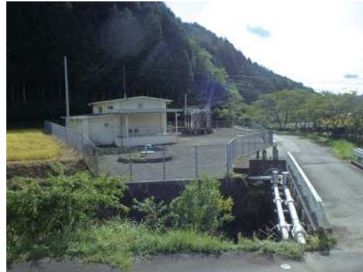
下流の浄水施設(白川町)
