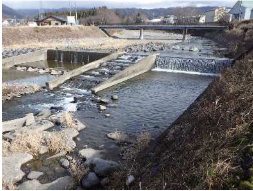
魚道の機能回復工事①(牛道川(郡上市))
