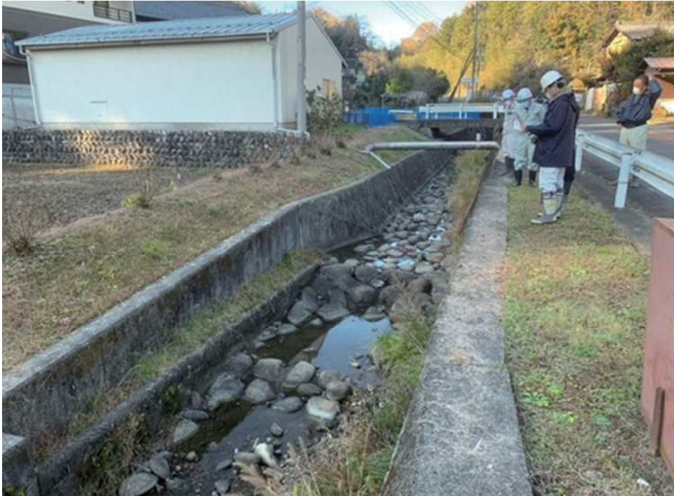
FWSによる魚道点検状況【雄鳥川(川辺町)】
