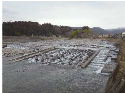
魚道の機能回復工事②(牛道川(郡上市))
