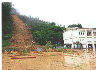
被災箇所（災害発生時：下呂市）
