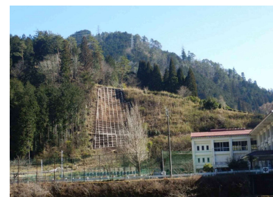
被災箇所（復旧完了時：下呂市）
