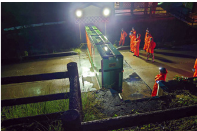
勝山陸閘の閉鎖作業 (坂祝町)
