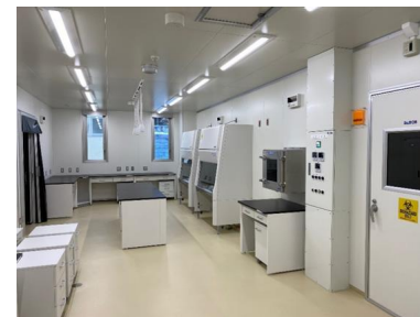
ウイルス検査室
