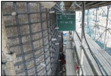
橋脚補強（施工中）
