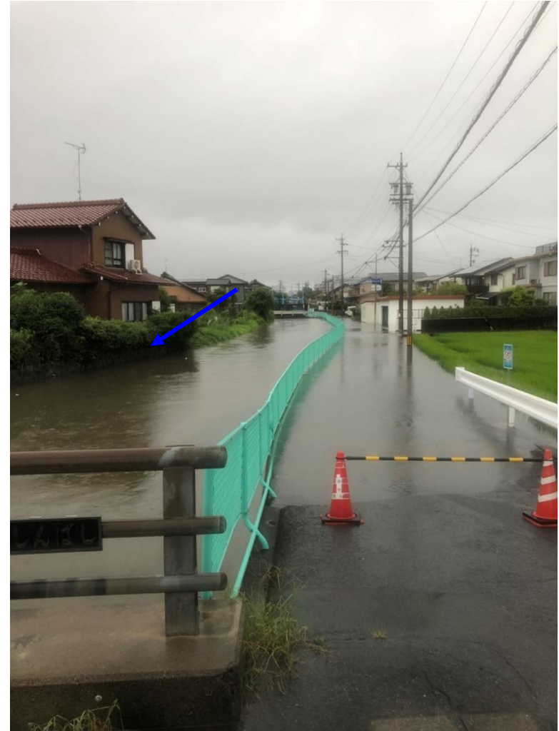
新橋より上流側を望む
