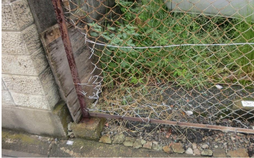
現場写真②:フェンスの一部に開いた穴 平成 25 年 9 月撮影
