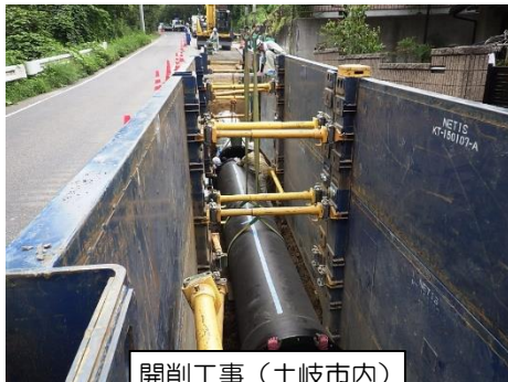
開削工事（土岐市内）
