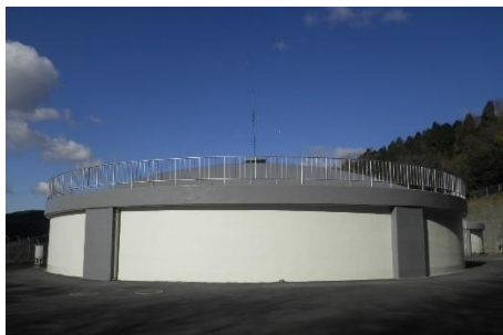
水道タンク外面補修状況（瑞浪市内）
