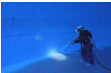
水道タンク内面補修状況（瑞浪市内）
