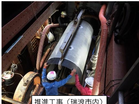
推進工事（瑞浪市内）
