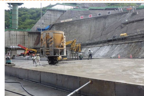
コンクリート打設状況
