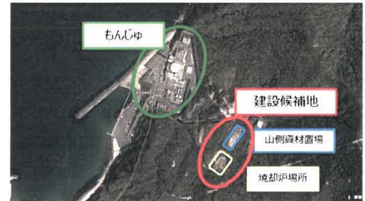
新たな試験研究炉の建設候補地
