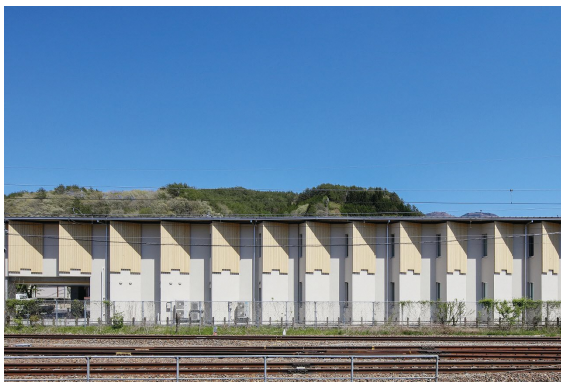
例) 音の入射角の調整 隣接する線路音に対し、緩衝材や壁面形状の工夫 (上松町役場)
