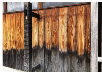
雨による木材劣化 (気象劣化)
