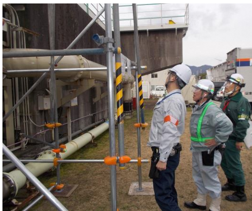
安全パトロールの様子
