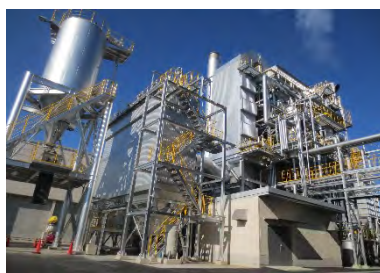
木質バイオマス発電施設（瑞穂市）
