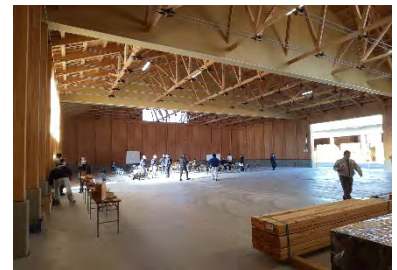
県産材により大空間を実現した製品保管倉庫の内覧会
