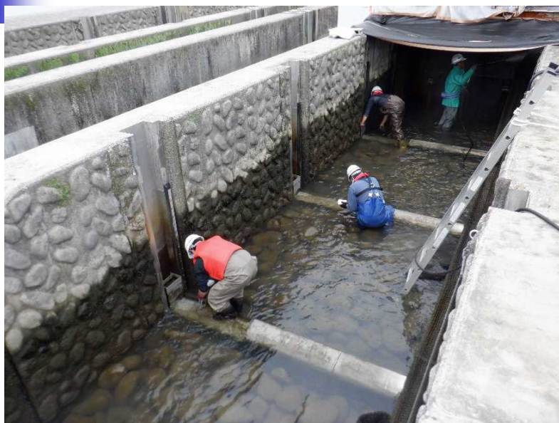
左岸呼び水式魚道の清掃状況 （令和3年5月）
