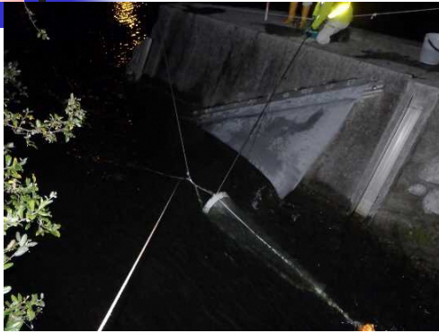
プランクトンネット設置状況 （せせらぎ魚道）
