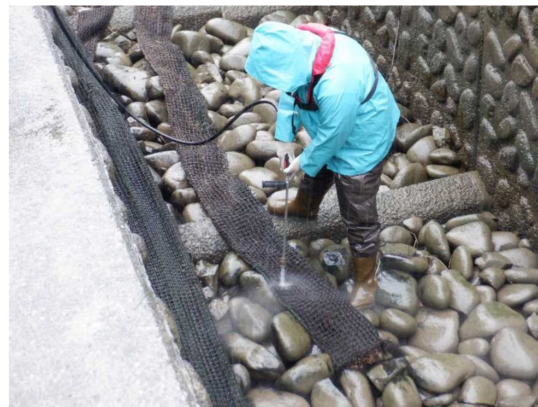
右岸呼び水式魚道の清掃状況 （令和3年4月）
