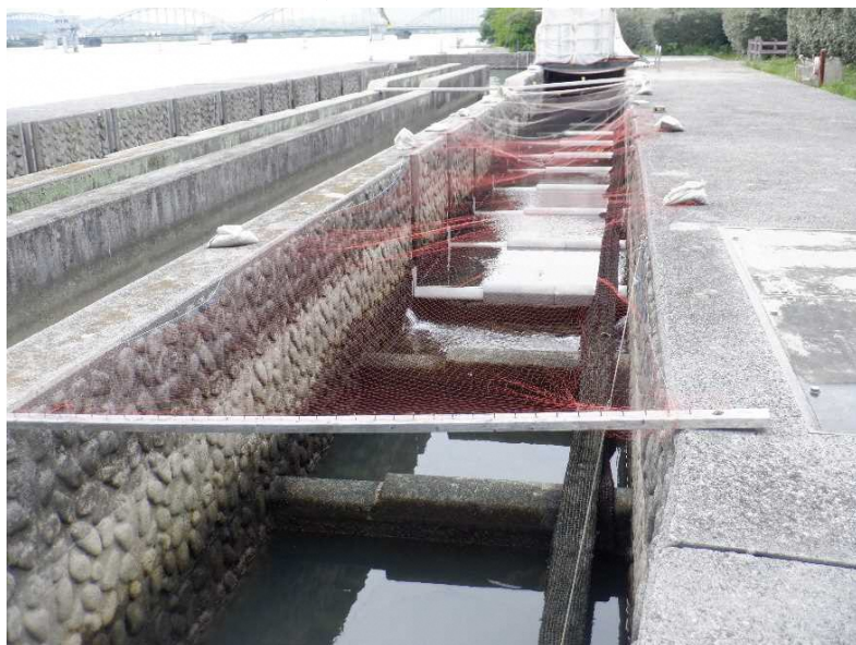
呼び水式魚道への防鳥ネットの設置状況 （令和3年5月）
