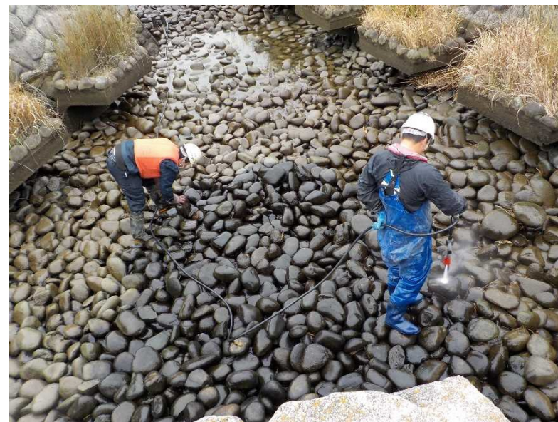
右岸せせらぎ魚道の清掃状況 （令和3年4月）
