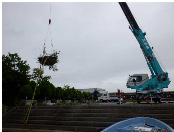
漂着物の陸揚げ作業 (令和3年8月)
