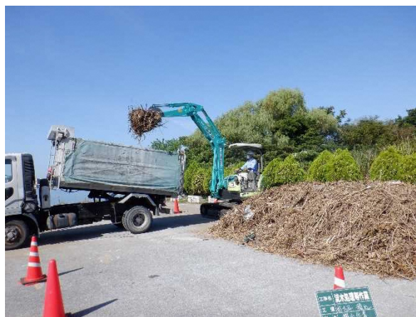
漂着物の搬出作業 (令和3年8月)
