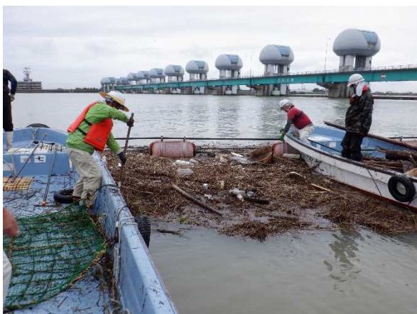
堰上流に滞留した漂着物の回収作業 (令和3年8月)
