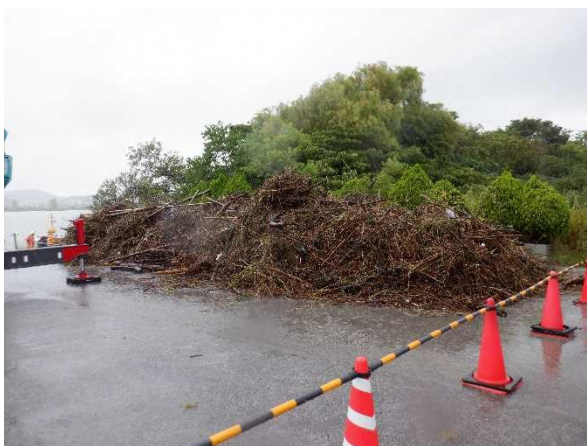
陸揚げされた出水時の漂着物 (令和3年8月)
