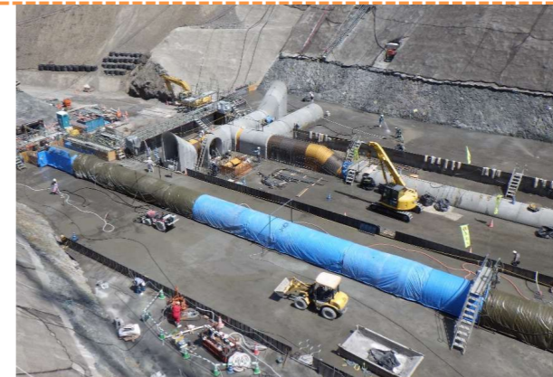
堤内仮排水路設置状況
