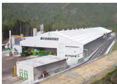
合板工場（中津川市）
