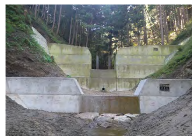
流木捕捉式治山ダム
