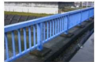
⑥鋼製高欄
