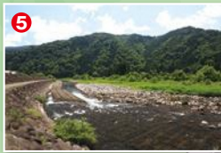
5 越佐橋下流の瀬がカーブする位置にある護岸帯。護岸際の流れ込みからしばらくは深瀬
