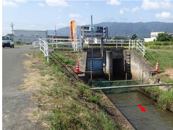
写真 3.9 水門の開放状況 (H28 実施)
