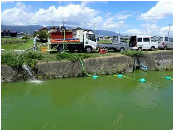
ポンプによる汲み上げと排水
