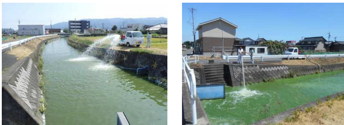
図 2.8 高圧水による水面攪拌の実施状況（令和元年 8 月 1 日、馬目橋付近）
