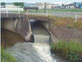
9-③ 用排水路・河川落差解消前
