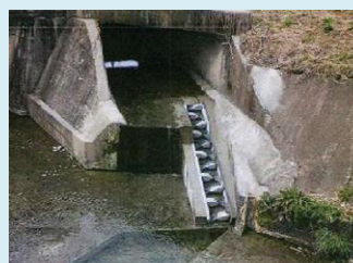
9-③ 用排水路・河川落差解消後
