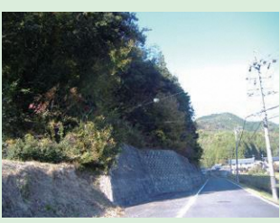
2-② バッファーズーン整備前
