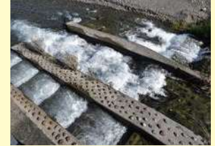
魚類が遡上するための呼水式魚道
