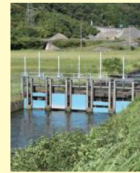
取水や洪水の逆流防止などのため、水路には水門や樋門が設けられています
