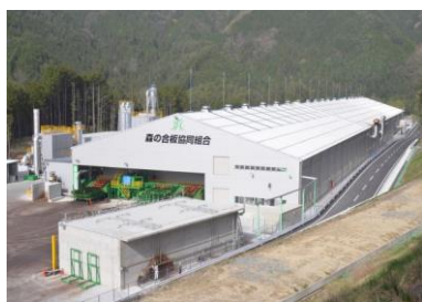
合板工場（中津川市）
