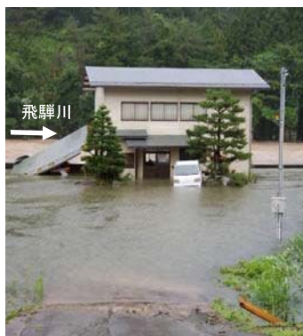
飛驒川 無数河地区の浸水状況 (R2.7)
