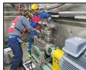
仮設中圧ポンプ接続訓練
