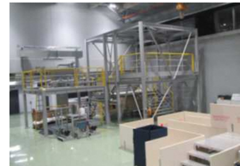
事務所棟 訓練施設
