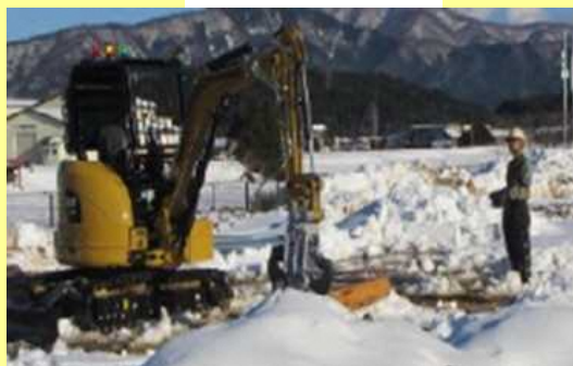
無線重機訓練
