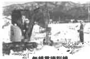
無線重機訓練
