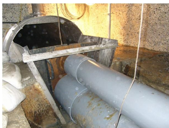
仮設水路(パイプ)の施工
