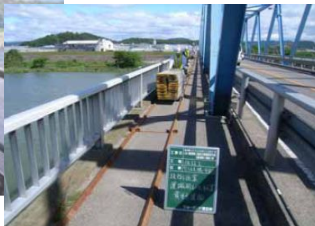
通路足場およびレールによる資材運搬状況
