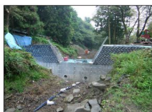
砂防えん堤復旧 9/3完了 上流側より望む
