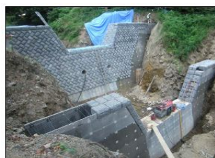
砂防えん堤復旧 9/3完了 下流側より望む
