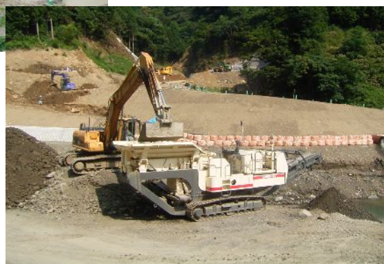
ソイルセメント母材ふるいわけ作業における自走式破碎機の導入
