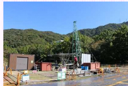
「もんじゅ」の敷地内におけるボーリング調査（2021年10月）
