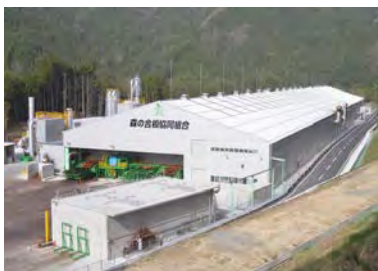
合板工場（中津川市）
