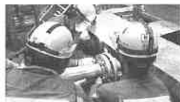
現場実地訓練 (緊急発生時連絡用仮設中仕込みの連絡船中仕組への接続)
